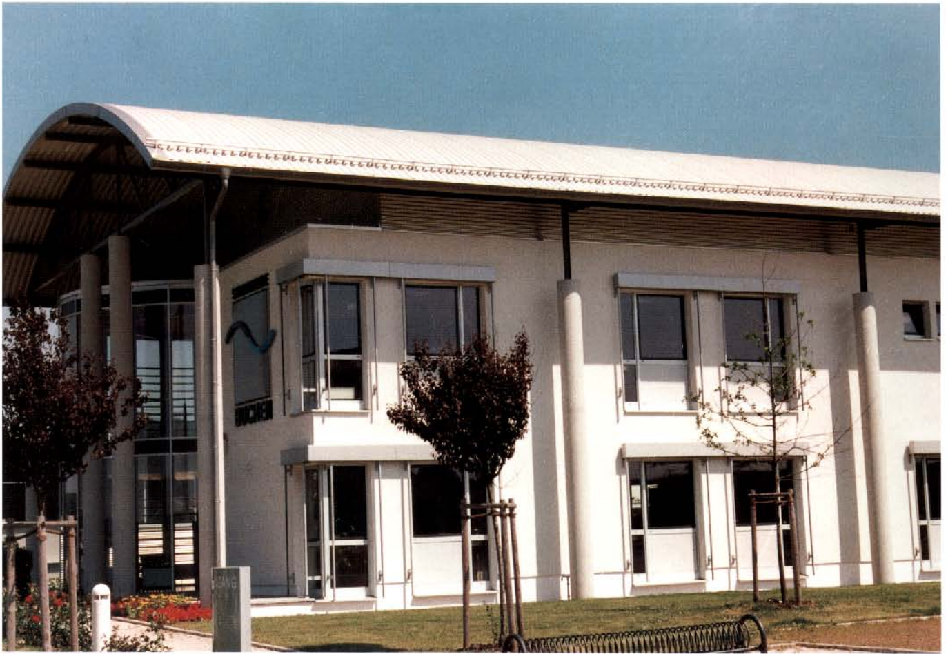
obrepa Doppelrohr-System auf den Gebäuden der Stadtwerke Buchen, Odenwald
